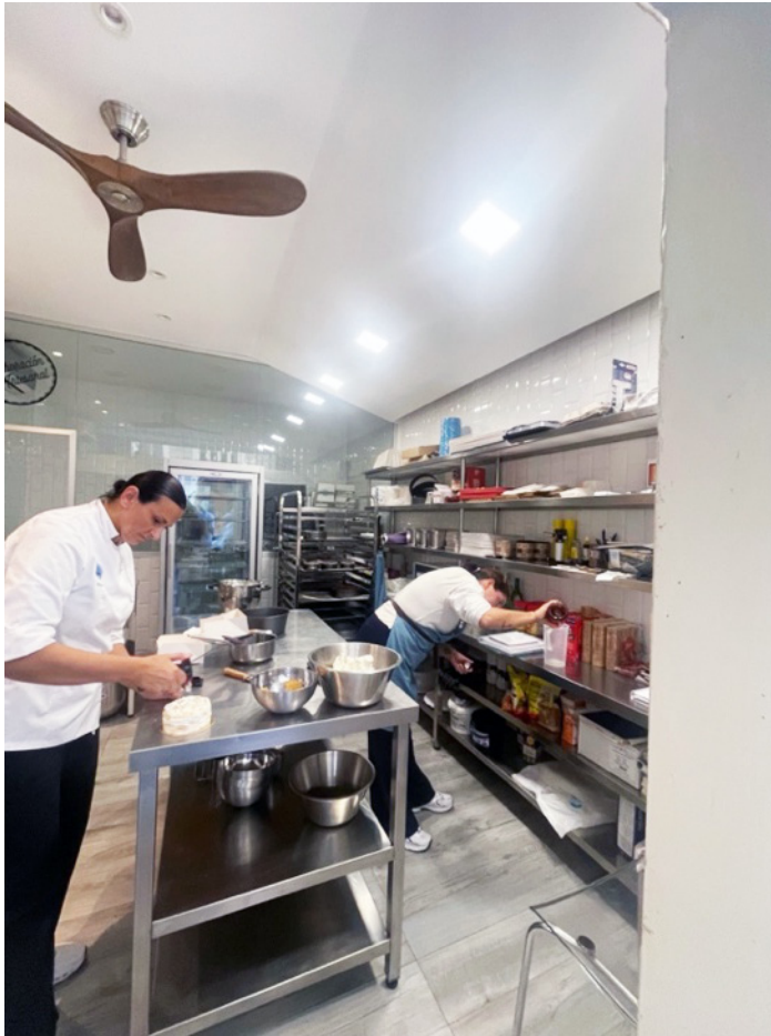
Tartería Amparo Serrano: Implementación de iluminación led
